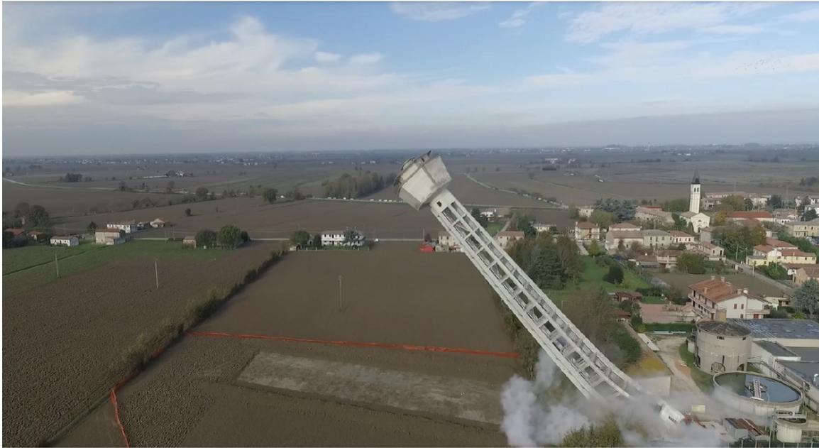
*Abbattimento serbatoio pensile della centrale di potabilizzazione di Canalnovo
